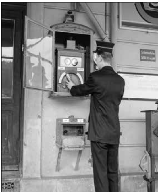
Hipp'sche Wendescheibe als Vor- und Hauptsignal in Bischofszell-Stadt mit Schalttafel, 1967
