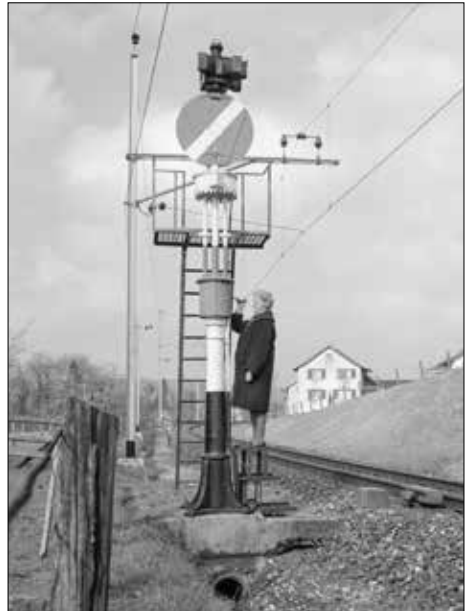
Hipp'sche Wendescheibe als Vor- und Hauptsignal in Bischofszell-Stadt mit Schalttafel.
